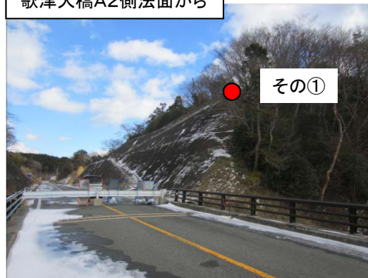
歌津大橋A2側法面から
