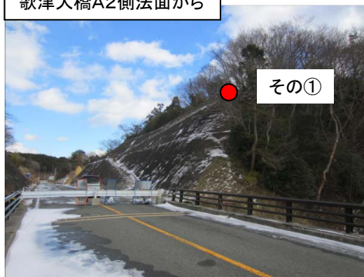
歌津大橋A2側法面から
