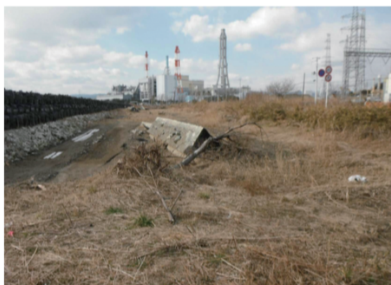
▲ 津波で壊れた防潮堤の一部
