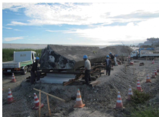
▲ 防災緑地内に設置される様子
