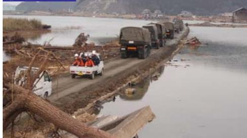
津波による道路兼用堤防流出。道路兼用堤防で交通路を確保(暫定1車線で供用)。
