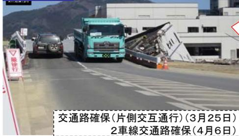
起点側橋台背面の盛土が全て流出した箇所(流出道路延長L=11m)をまたぐ応急組立橋を架橋し、3月25日に国道340号と連結する交通路確保、4月6日2車線確保。
