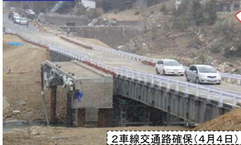
橋台両側の背面盛土が流出した箇所(流出道路延長 仙台側L=約30m、陸前高田市側L=約20m)をまたぐ応急組立橋を架橋し、4月4日交通路を確保。
