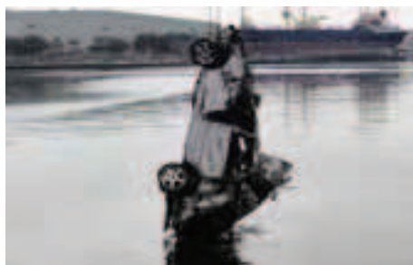
航路啓開状況・仙台塩釜港（沈んだクルマの除去）
