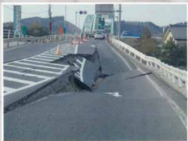
国道45号路面崩壊（宮城県石巻市） 【出典：東北地整】
