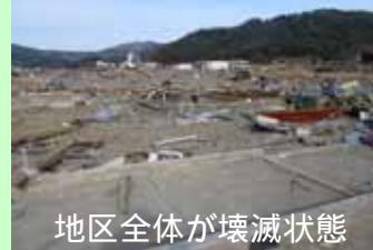
石巻市雄勝地区
