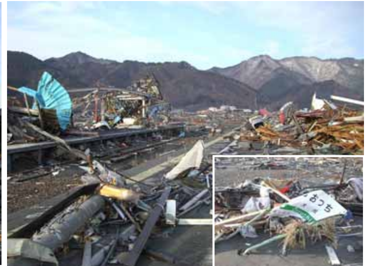
大槌町内の被害状況 (JR大槌駅)
