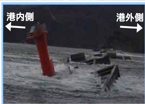
津波により北堤の大部分の防波堤が港内側に傾斜・転倒
