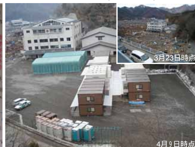
津波により使用不能となった役場の代替となる仮庁舎が完成
