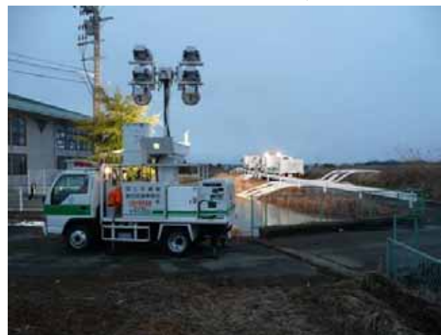
搜索、復旧作業に向け夜間も排水作業を実施 (宮城県東松島市)
