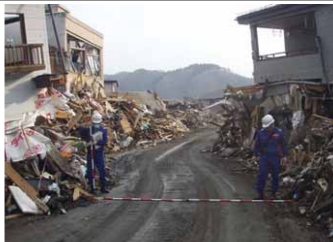
道路の損傷状況、車両の通行可否をTEC-FORCE隊員が調査(岩手県宮古市)
