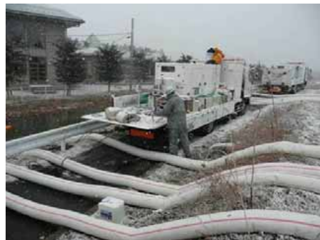
降雪の中、排水作業の準備を行う協定業者 (宮城県東松島市)
