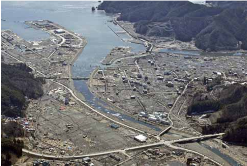
被災後(平成23年3月撮影)
