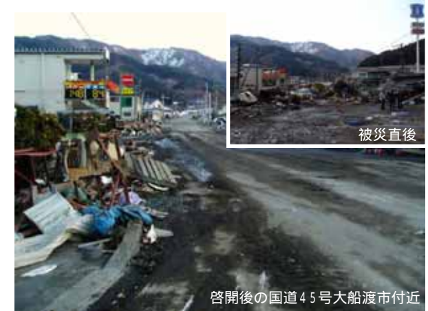
支援物資輸送等の拠点となる港湾と周辺地域を結ぶ道路を被災後すぐに啓開
