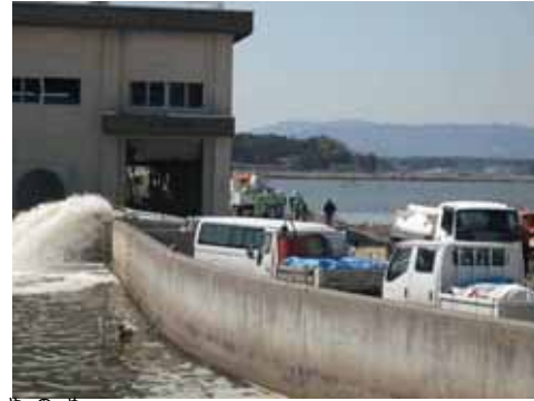
やのめ 矢ノ目川付近において、排水ポンプ車6台により、24時間体制で排水を実施(相馬市八沢地区)
