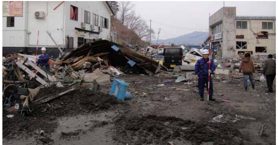
家屋の廃材や土砂に埋め尽くされた国道45号(地震直後の宮古市内)
