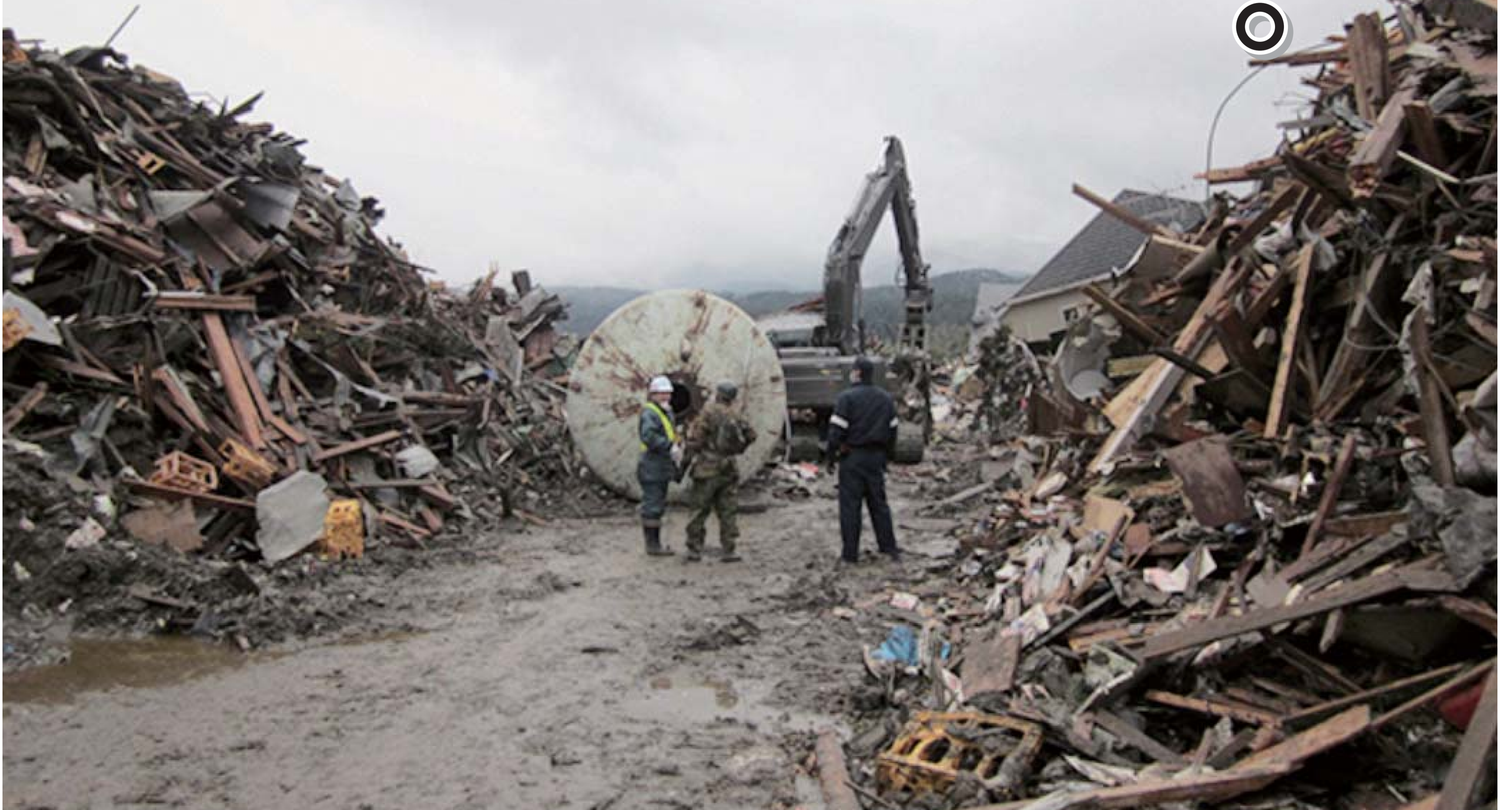
啓いた後の国道（岩手県陸前高田市）
