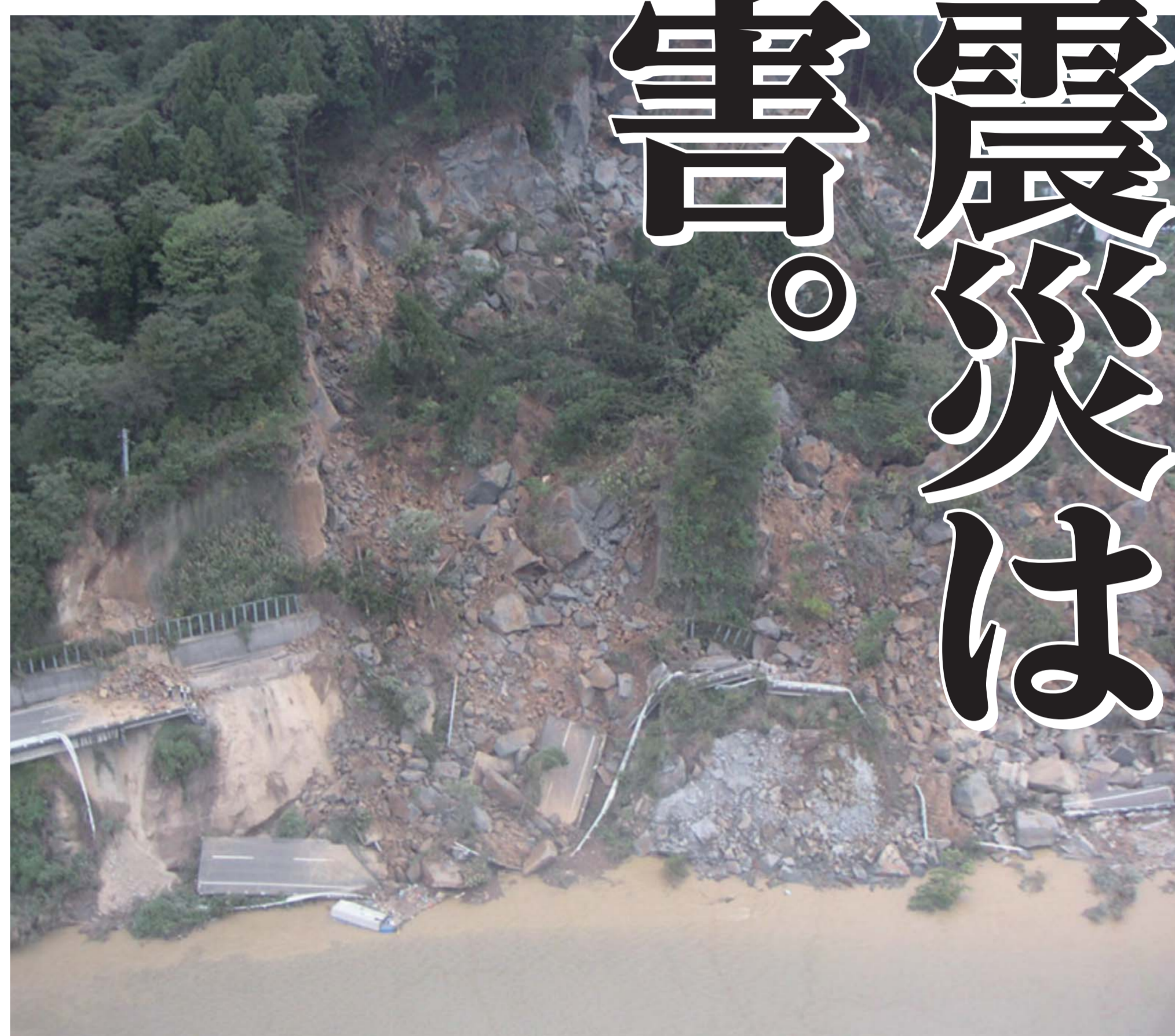
新潟県長岡市の土砂崩落で寸断された道路 (出典：北陸地方整備局)
