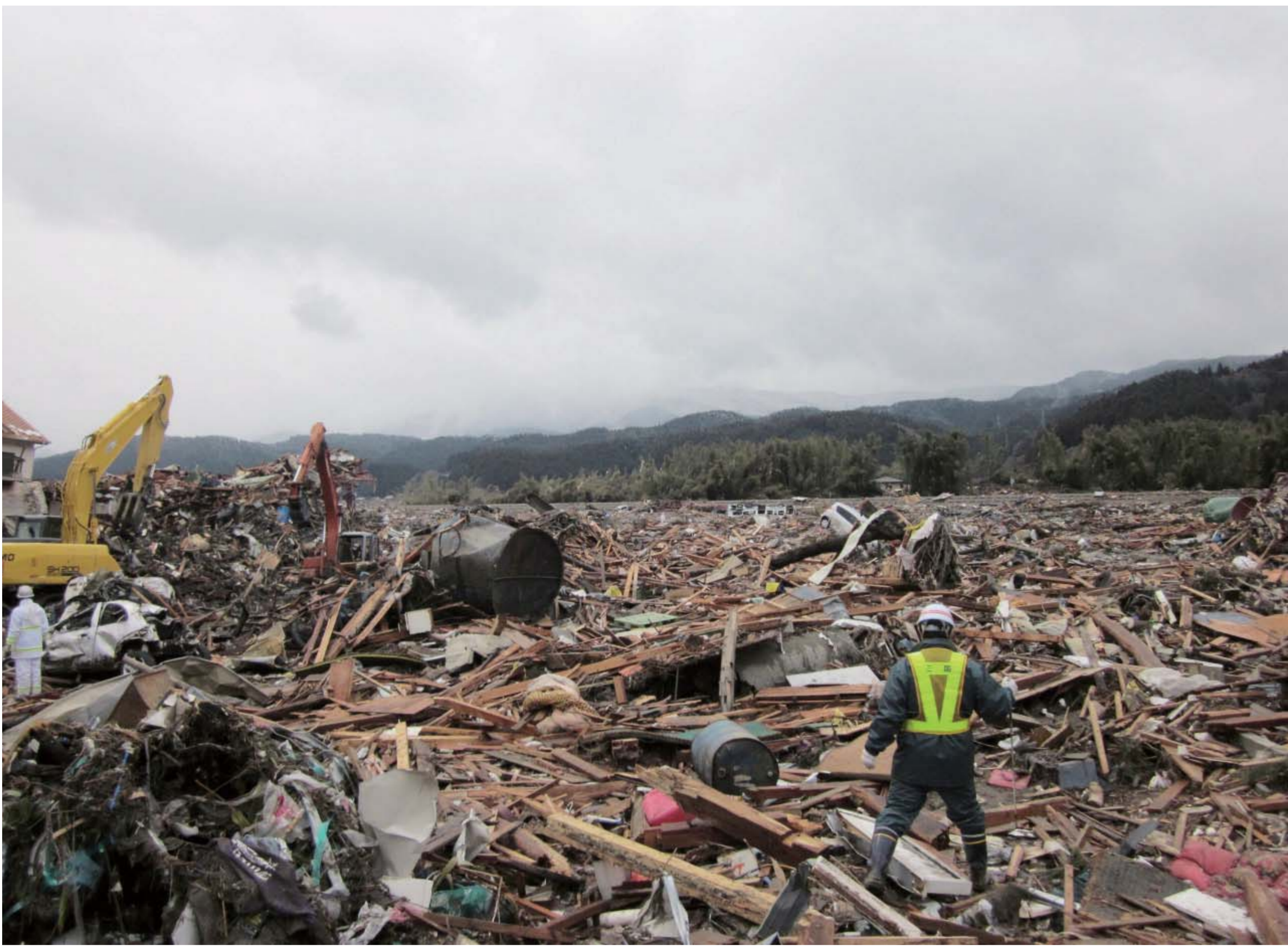
ガレキに覆われた国道（岩手県陸前高田市）
