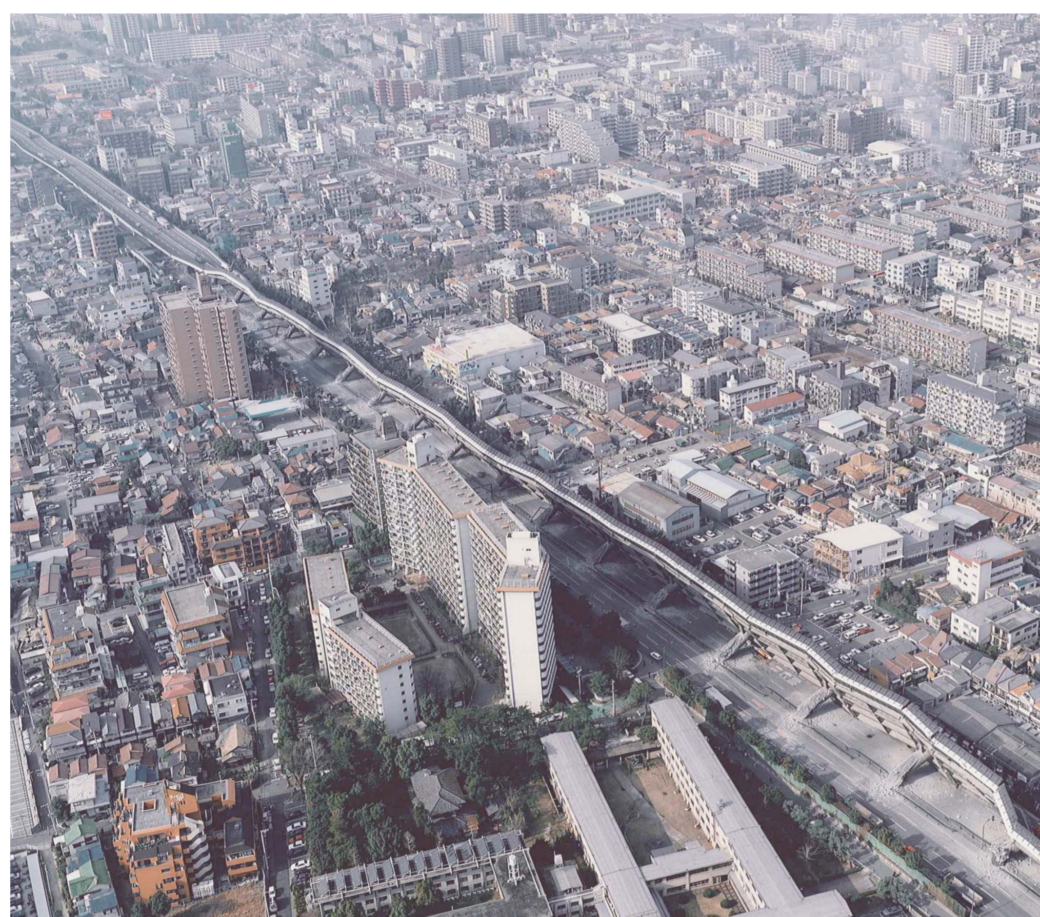
阪神高速の高架道路の倒壊 (出典：近畿地方整備局)
