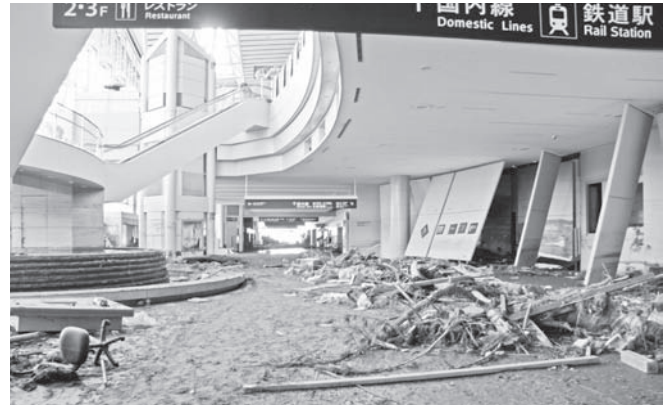
▲相野釜地区の方々が多く避難した仙台空港ビル1階の様子
