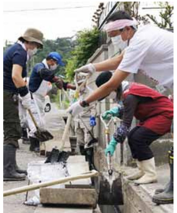
◀山形県東根市から「マユくらんぼ」がしね元気隊パート2として市民のボランティア17人が訪れ、被災家屋の泥だしや洗浄、ガレキの撤去、側溝の清掃などを行いました(7月21日、新東名地区)
