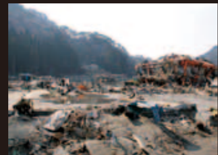
左手前の基礎部分から大きく流れた黎明館
