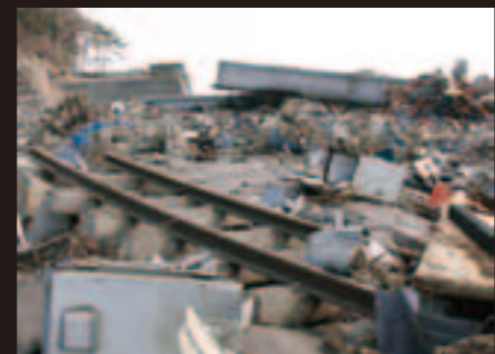
三鉄の高架は崩れ落ちレールも流された
