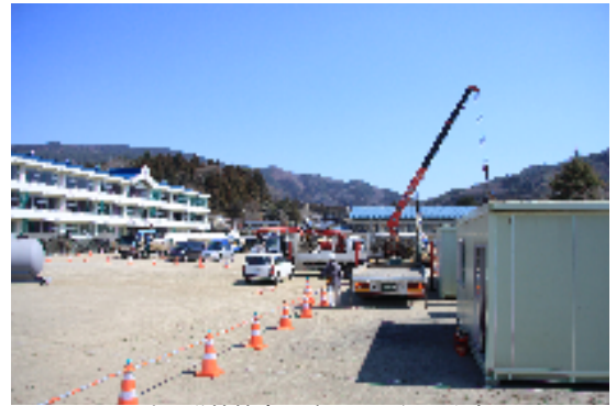
米崎小学校校庭に建設中の仮設住宅
