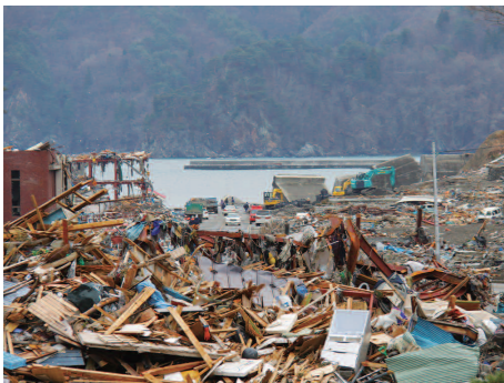
←防潮堤が決壊し、壊滅的な被害を受けた両石町。まちは消滅し見渡す限りがれきの山と化した
