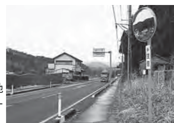
国道395号の上浦地区付近。カーブミラー設置後
