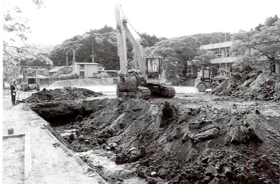
校庭の表土はぎ作業
