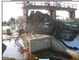
応急復旧状況
