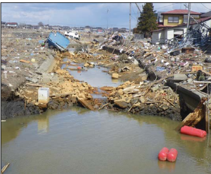
九号排水路(亘理町)
