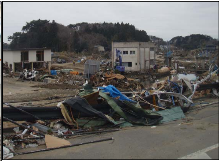
中下排水機場(東松島市)
