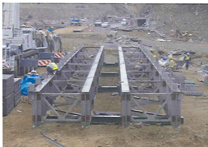
▲組立式橋梁の組立状況
