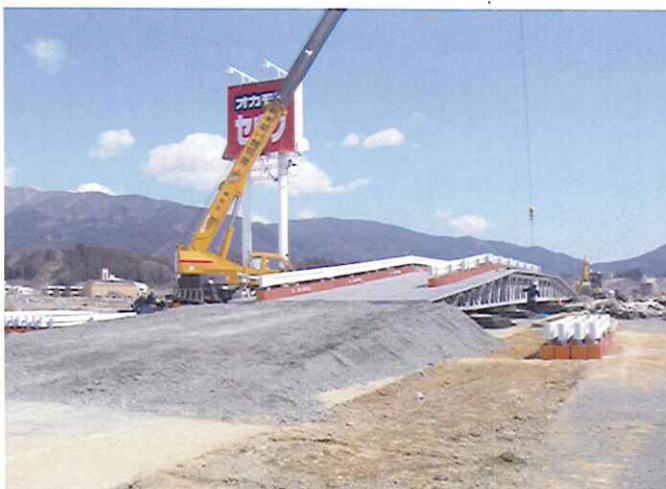
▲北陸地整による応急組立橋設置状況
