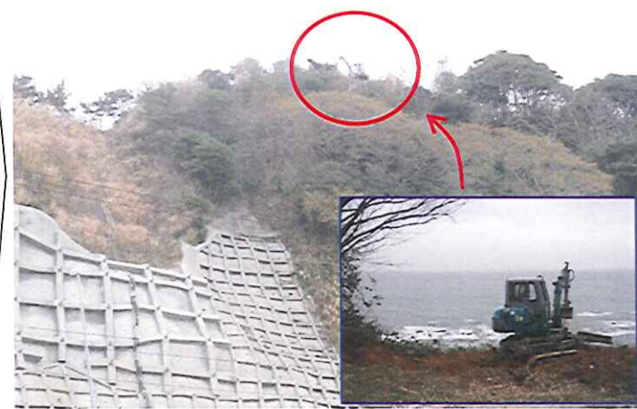
▲四倉法面亀裂対策(蟹洗温泉正面)
