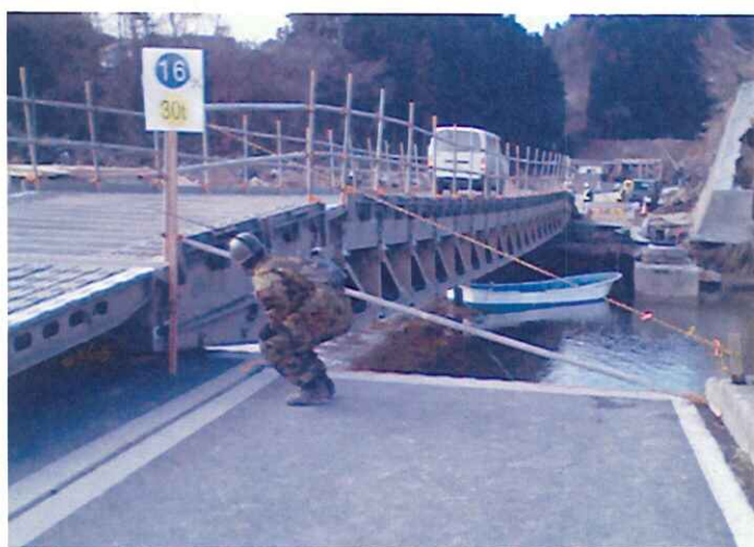
▲ 自衛隊による組立式橋梁設置後(3月19日7時40分片側交互通行開放)
