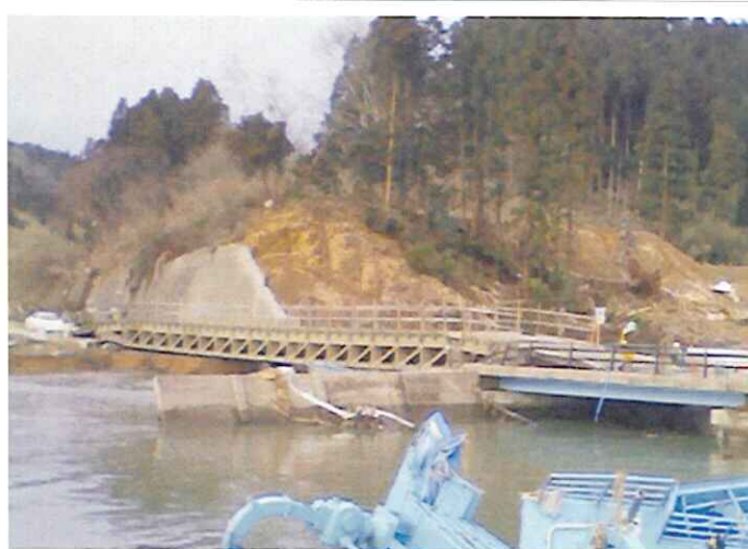
▲ 自衛隊による組立式橋梁設置後(3月19日7時40分片側交互通行開放)
