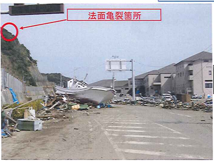
▲地震後の状況(いわき市四倉町)
