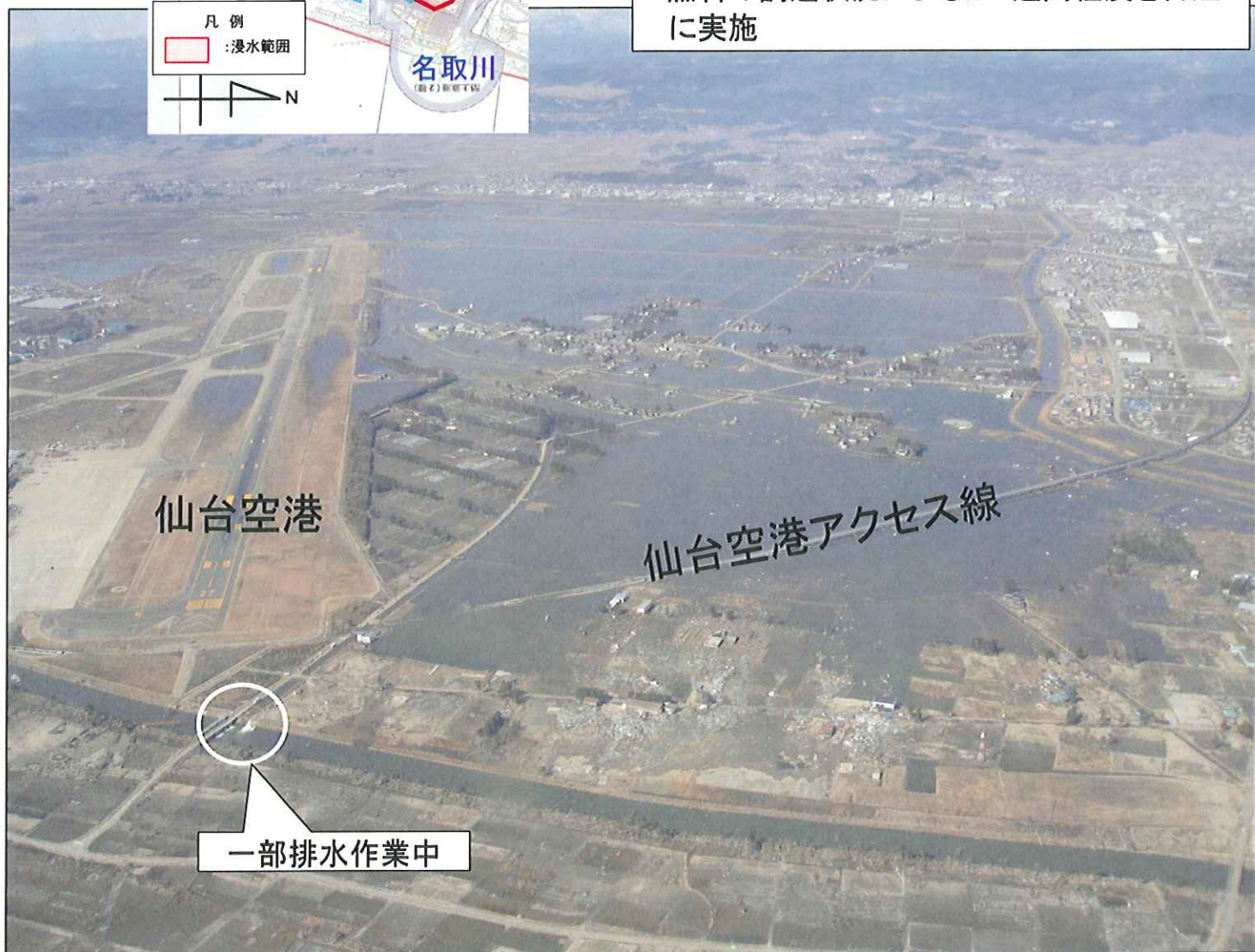
【仙台空港北部の浸水状況】
