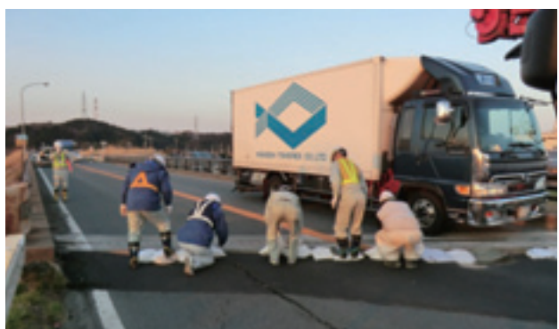
国道6号段差応急復旧作業(4月12日)
