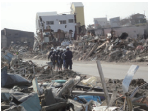
宮城県石巻市門脇の被災状況(4月18日)
