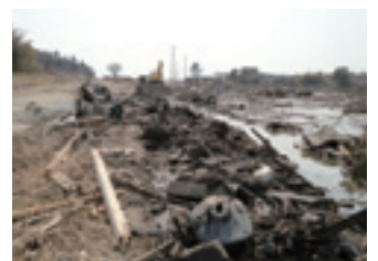
▲自衛隊立会いのもと素掘り排水路を掘る
