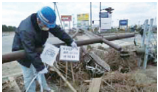
国道45号遺構被害調査(4月3日)
