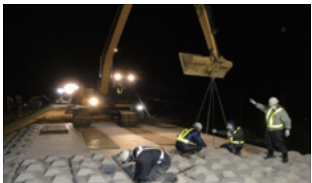
鳴瀬川の緊急復旧状況(写真提供:東北地方整備局)
