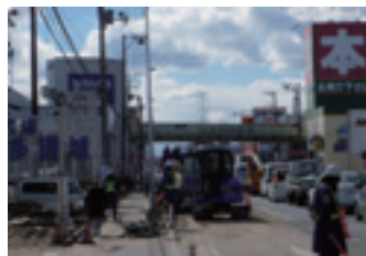
▲12.2kP上り線障害物撤去中 (4月4日 14:00)
