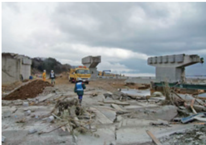
国道45号沼田跨線橋調査(4月5日)
