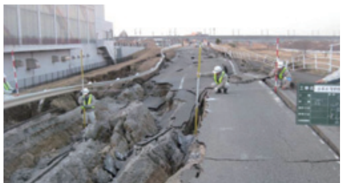
江合川の緊急復旧状況
