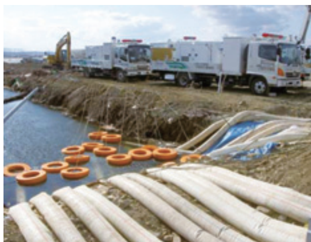
排水ポンプ稼働(宮城県東松島市4月3日)
