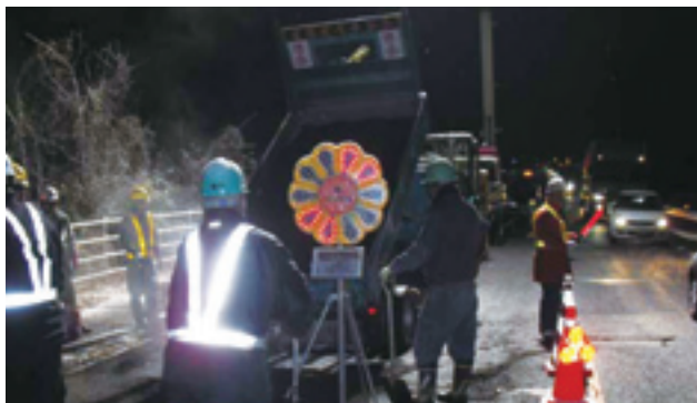
国道4号段差補修 交通誘導(3月11日)
