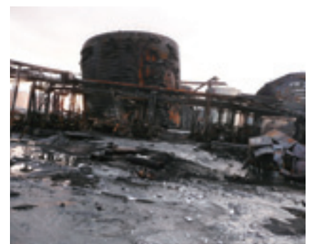
▲仙台石油精製所の焦げたタンク
