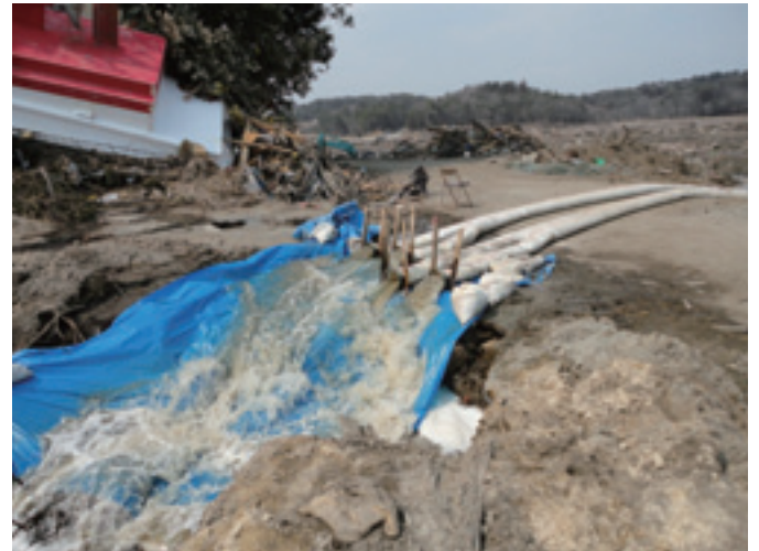
▲水神沼の釜場を1m下げて排水を再開
