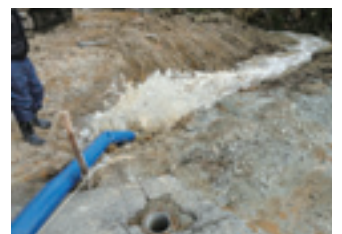
▲ポンプ設置から排水まで約1時間
