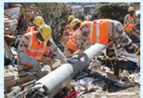
電信柱撤去作業を行うインド隊員たち
