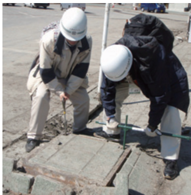
国道6号橋梁点検(4月2日)
