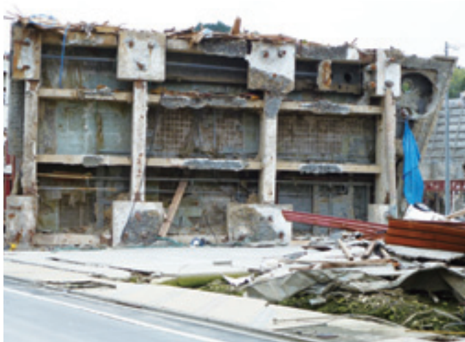
▲女川町 倒壊した建物(基礎杭が引き抜かれている:右端の杭)
