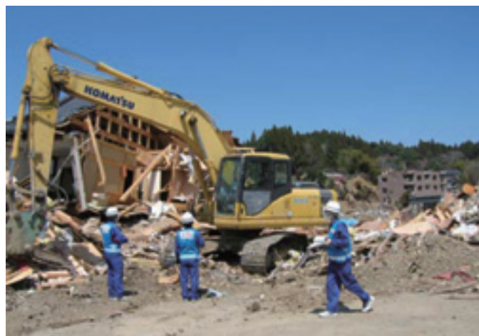
ガレキ撤去状況確認(宮城県気仙沼市4月17日)
