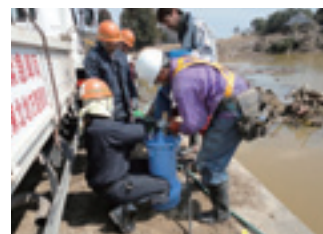
▲排水ポンプの設置状況
