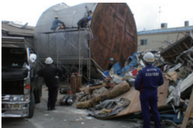
タンク撤去のための現地調査(東北地方整備局リエゾン)
