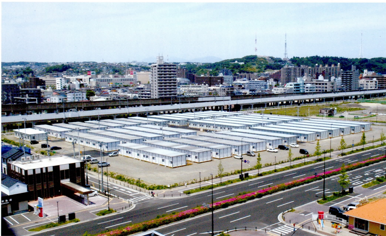
あすと長町38街区仮設住宅
