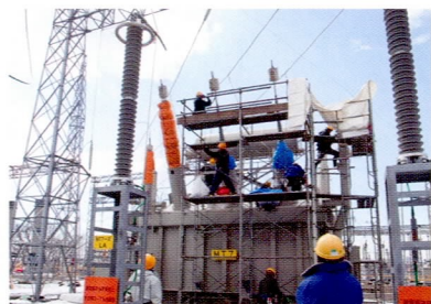
仙台変電所復旧作業
