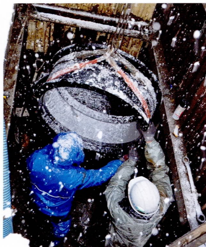
雪の中で懸命に続けられる水道復旧作業 (3月17日、泉区南光台)
