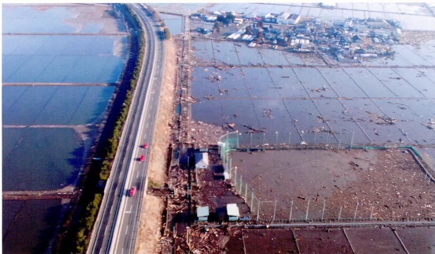
仙台東部道路付近
