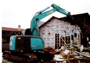
家屋の解体・撤去
