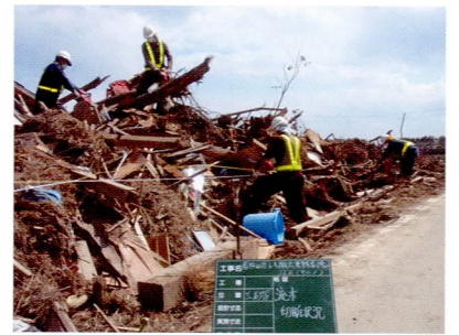
重機の入れない場所や細かいがれきなど、人力で撤去作業を行う現場も多数あった[仙台建設業協会提供]
