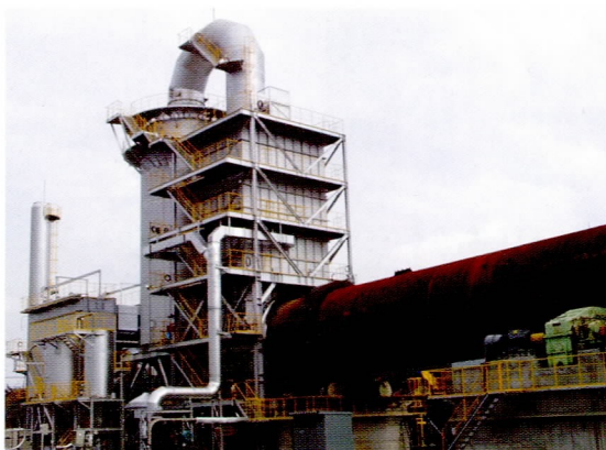
仮設焼却炉(若林区荒浜)
