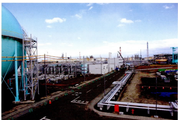
震災直後（上）と12月9日現在（下）のガス局港工場。大きく損壊したLNG出荷用配管の修繕に当たっては、深さ10mのくいを入れた基礎と固定器具の強化により津波対策を施した
