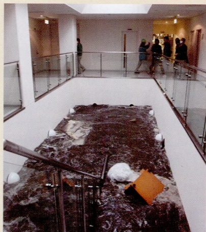
工場施設は激震に耐えたが、津波は建物内に浸水し、電気設備などが甚大な被害を受けた
