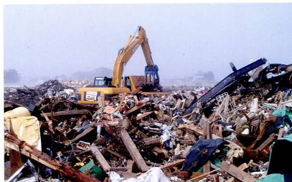
がれき撤去の開始について、いかに早く多くの人に周知するかが問われた。平成24年度以降は、津波堆積物をいかに効率良く処理するかが課題となる
