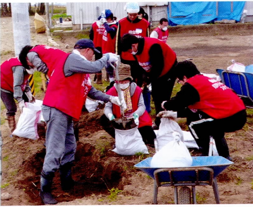
スコップでかき出した泥を土のう袋に詰め、一輪車で集積場所へ運ぶ。高圧洗浄機による壁や塀の洗浄、石灰消毒、がれきの片付けなども行った [仙台市社会福祉協議会提供]
