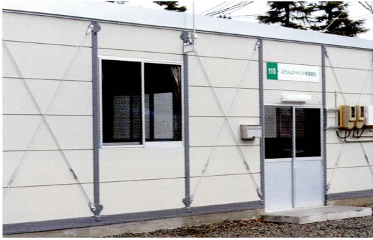
事務所・倉庫として兼用している仮設工場。製品の性質上必要な空調設備もない不便な環境だが、世界中の顧客からの需要を励みに力強く復興を目指す
