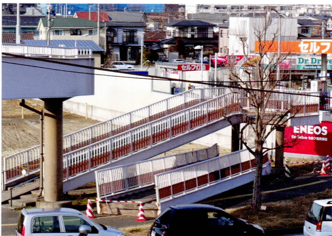
若林区遠見塚三丁目霞目の歩道橋では、階段部分が落下(3月13日)
