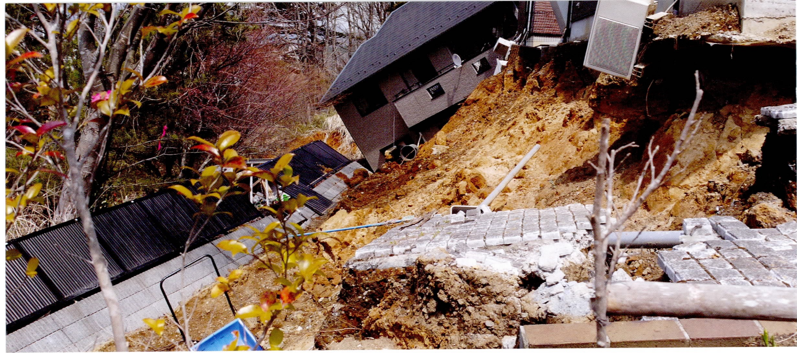
郊外丘陵部の宅地被害(青葉区西花苑)
