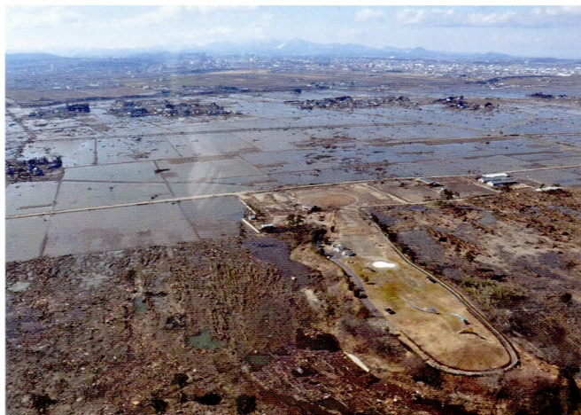
海岸公園冒険広場(若林区井土、3月18日)。広場内の展望台に避難した5人の命が救われた
