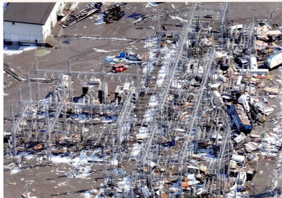
変電所の被災(宮城野区)
