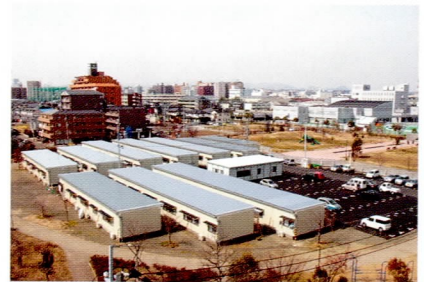
七郷中央公園仮設住宅
