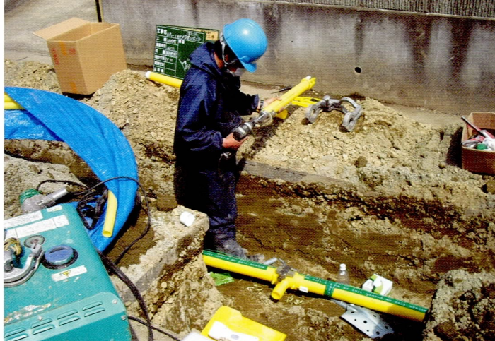
耐震性の高いガス導管（ポリエチレン製）への入れ替え工事
