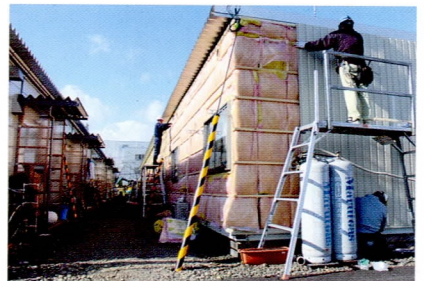
寒さが厳しくなる前に急がれる断熱材追加工事 (12月5日)
