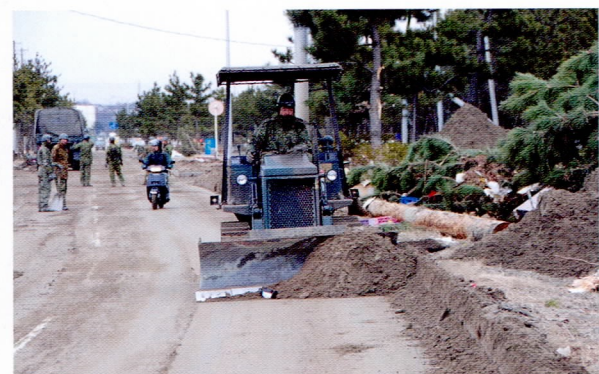
新港コンビナート地区の道路整備
