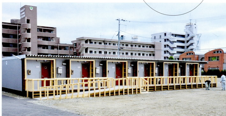
荒井土地区画整理事業小学校用地仮設住宅
