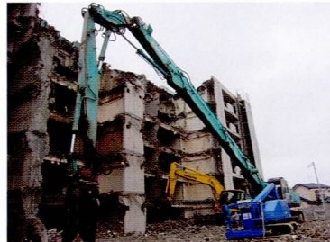
ビルの解体・撤去
