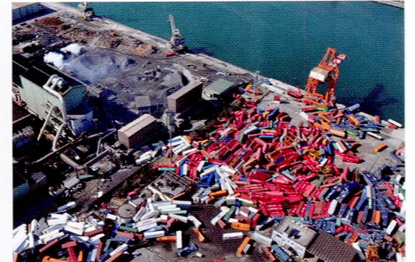
散乱するコンテナ (仙台塩釜港)
