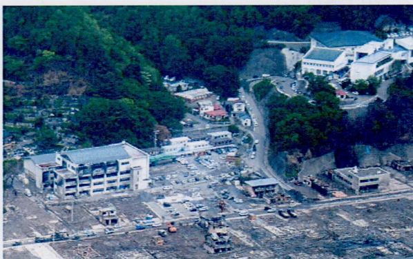
【大槌小学校校庭に整備された仮庁舎（中央）】
