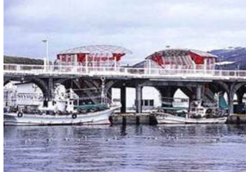
津波対策を講じた漁港施設
