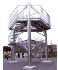
避難タワーの設置
