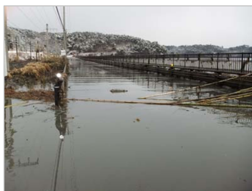
【津波による国道45号の冠水(須賀地区)】
