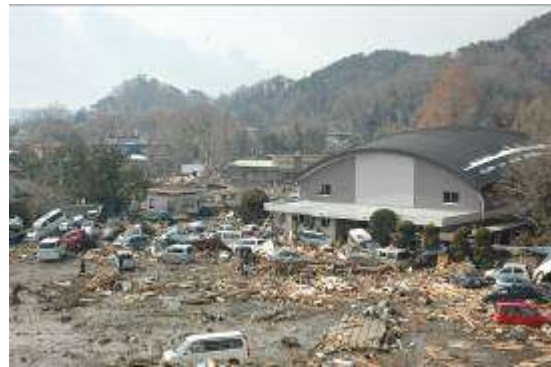
野蒜小学校(体育館)
