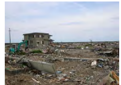
久之浜（海側）被災状況
